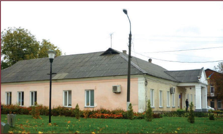
Приміщення по вул. Красинських, 7, де протягом 1994–2008 рр. знаходився районний архів
