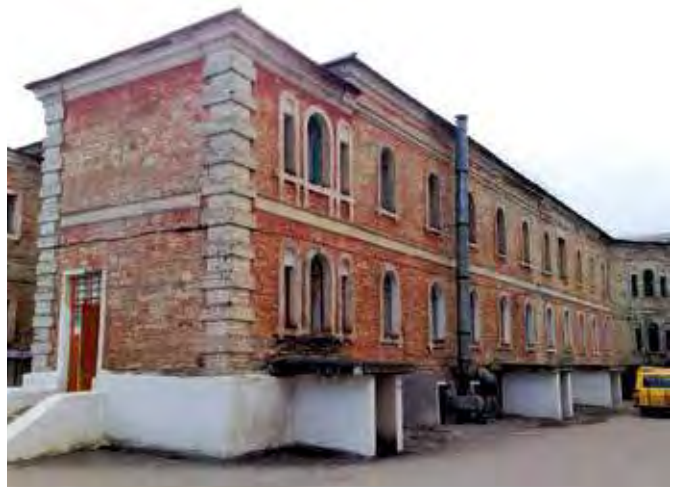
Міська лікарня у К-П (фрагмент крила центрального корпусу)
