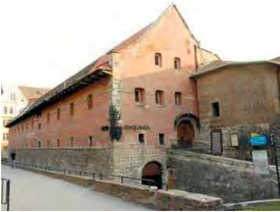
Будинок арсеналу у Львові
