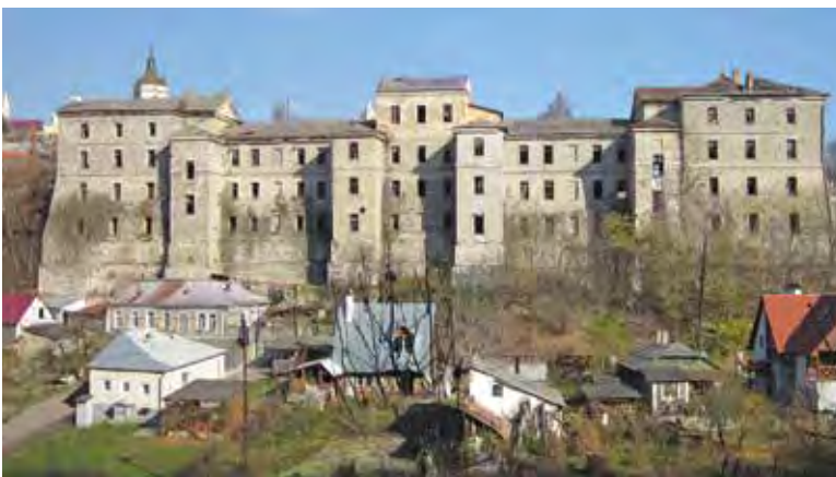
Приміщення казарм у Старому місті К-П. Сучасний вигляд
