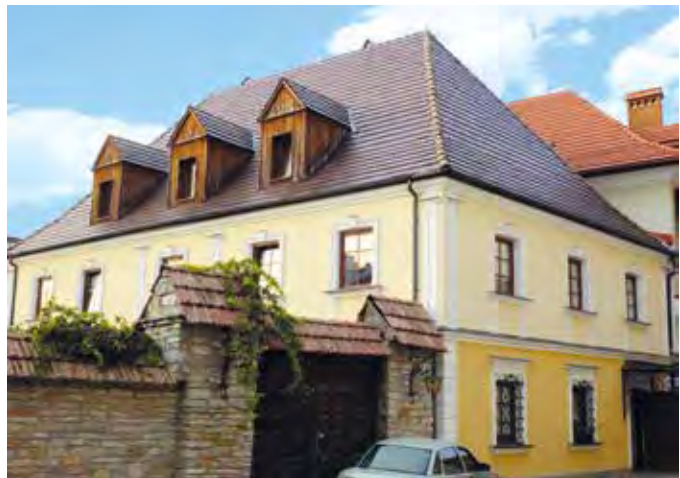
Реставрація житлового будинку, К-П, вул. Домініканська
