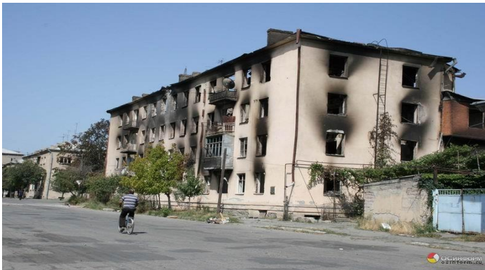
Постраждалі будинки в Цхінвалі
