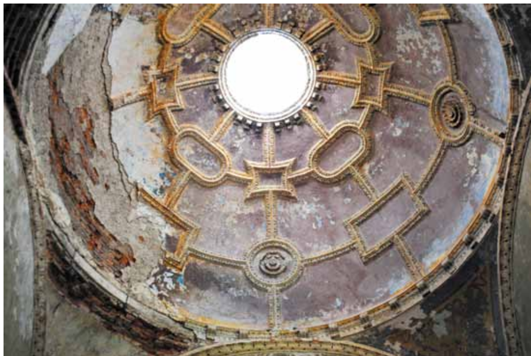
Кесонований купол каплиці Матері Божої Розарію. Фото Л. Жебровської Kasetonowa kopuła kaplicy Matki Boskiej Różańcowej. Zdjęcie T. Żebrowskiej
