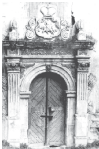
Чернелиця. Портал західного фасаду. ЛІАУ, I-24-4.
