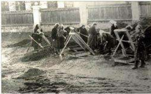
Студенти на будівництві бігової доріжки стадіону педінституту (1956 р.)
