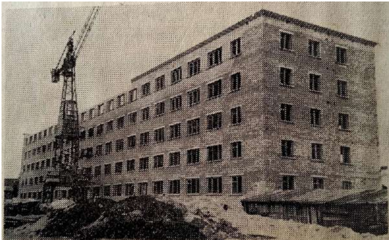
Загальний вигляд будівництва нового гуртожитку. 1965 р.
