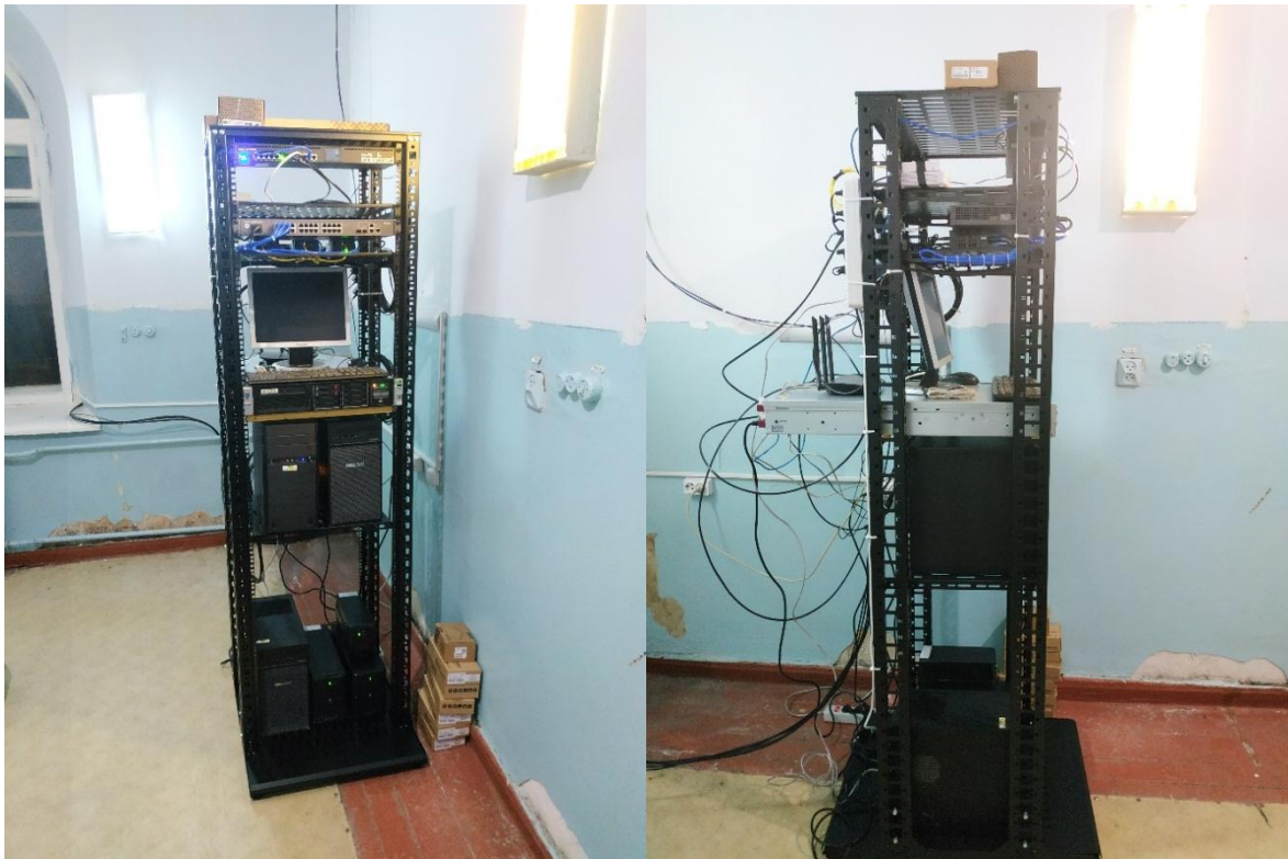
Рис. 2. Серверна стійка з головним мережевим обладнанням
