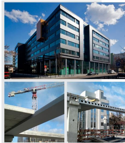
Рис. 2.6. Зелений будинок Skanska оснащений з'єднаннями Peikko
