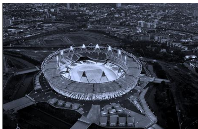
99% відходів від будівництва об'єктів направлені на утилізацію. Лондон 2012
